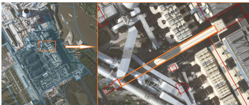
Rys. 1. Lokalizacja mostu skośnego nawęglania na terenie zakładu (kolor pomarańczowy), źródło: mapy.geoportal.gov.pl.
